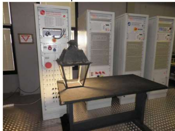
Inmunidad a los huecos de tensión, interrupciones breves y variaciones de tensión.
